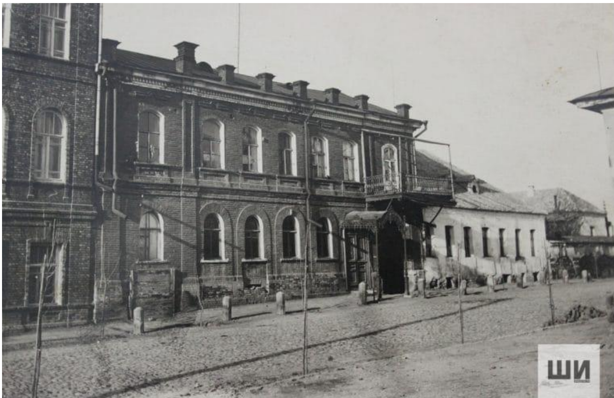
Здание по ул. Чернышевского,6. В 1941-1942 гг.- место размещения эвакогоспиталя № 1586.
