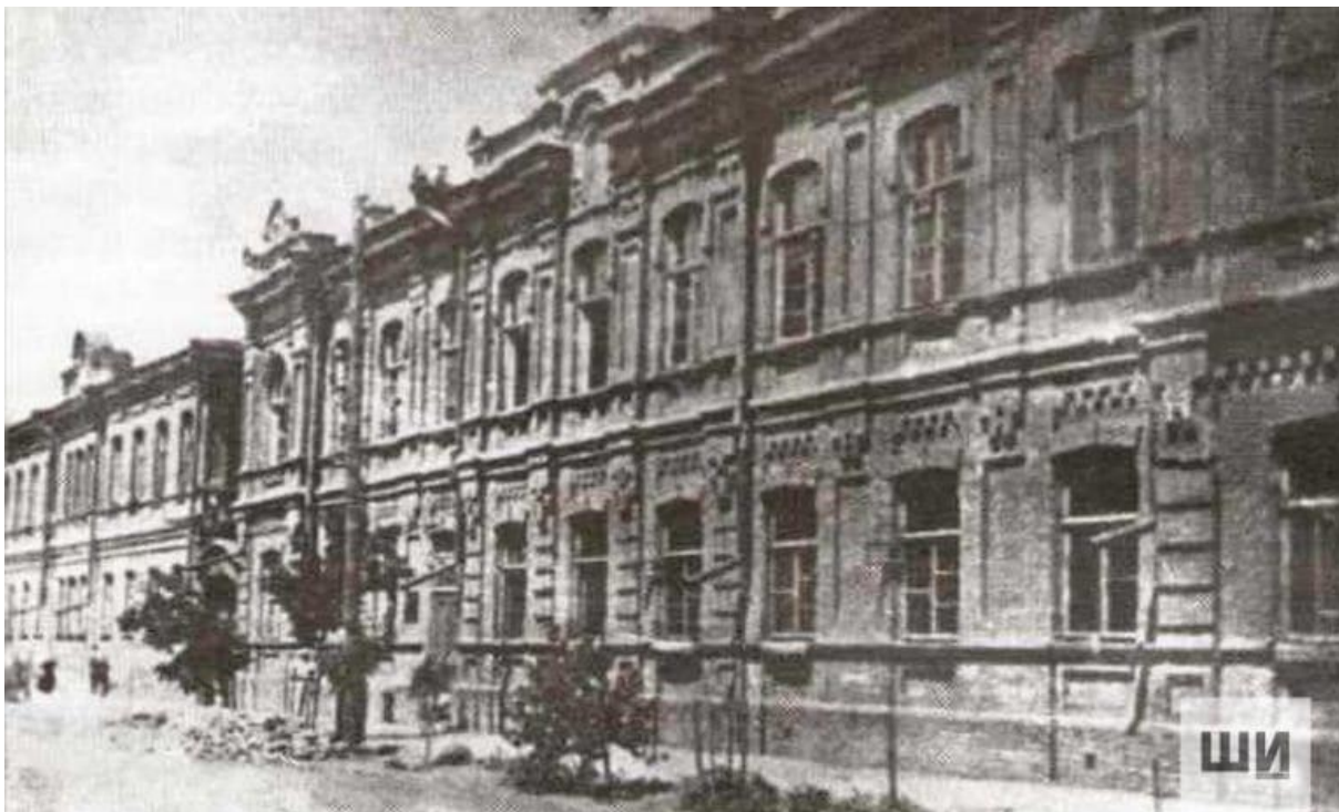
Здание по ул. Тургенева, 4. В 1941-1942гг.-место размещения эвакогоспиталю № 1008; в 1943г.- место размещения эвакогоспиталю № 5763. Фото из фонда библиотеки Астраханского автодорожного техникума.
